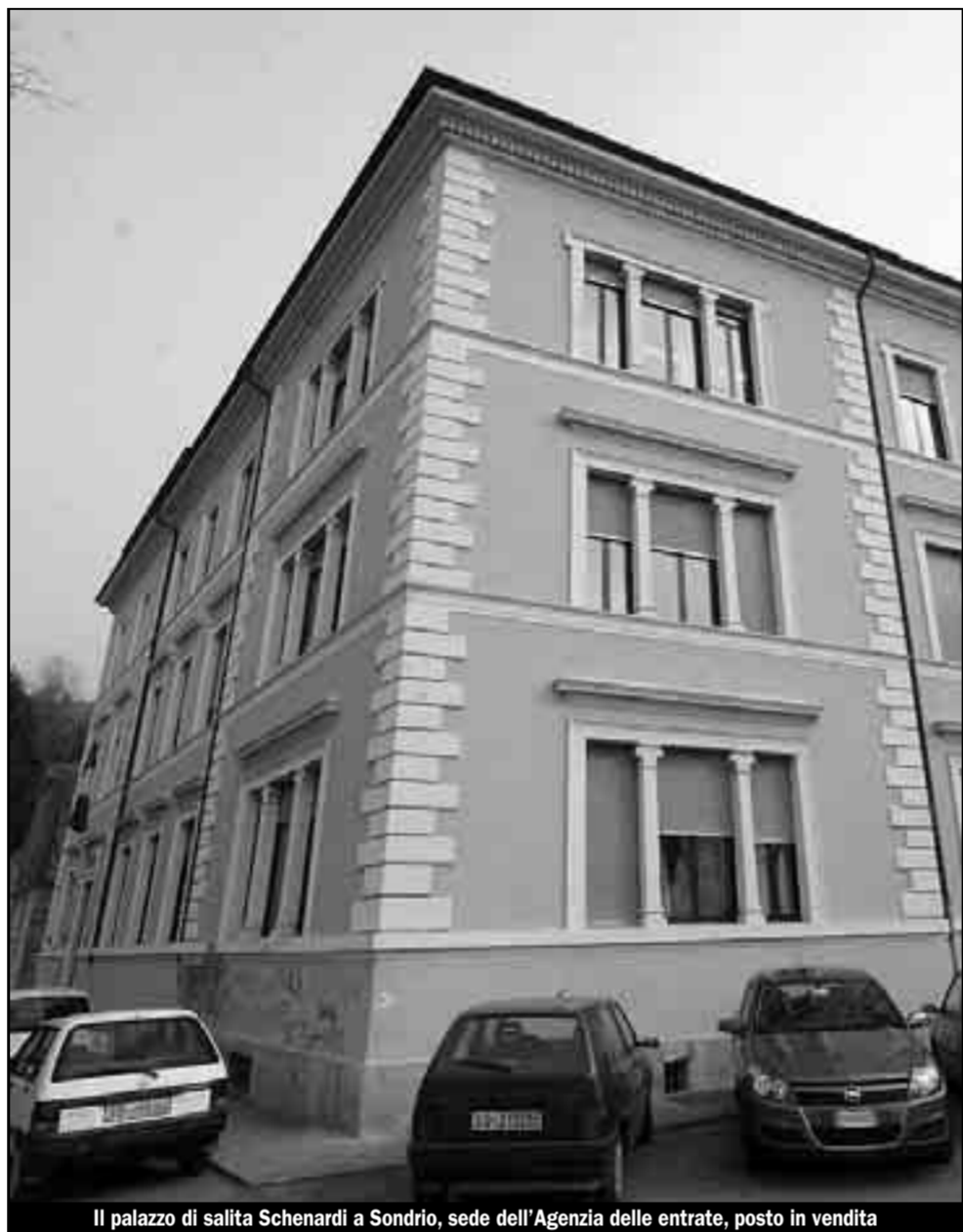
Il palazzo di salita Schenardi a Sondrio, sede dell'Agenzia delle entrate, posto in vendita
